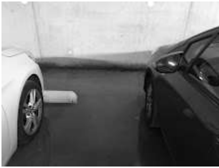
Lekkage noord 3.JPG 1645K
