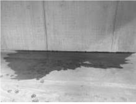
Lekkage west.JPG 1788K
