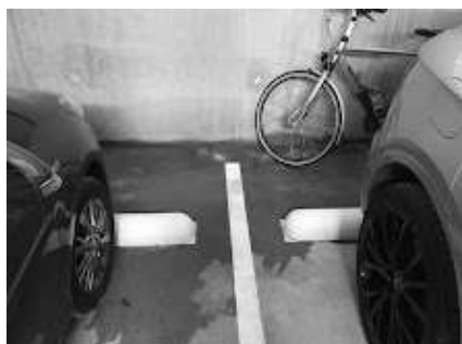
Lekkage noord 4.JPG 1938K
